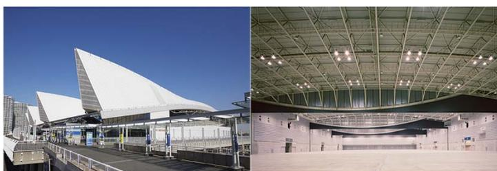
●展示面積: 10,000m<sup>2</sup> ●天井高: 最大19m ●床荷重5t/m<sup>2</sup>
